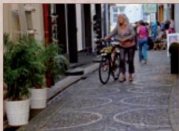
Natursteinpflaster bestimmen die Gassen und Plätze in der Freiburger Innenstadt. Häufig wurden Sandstein, Granit, Basalt, Porphyr und Rheinkiesel eingebaut. Der rötliche Buntsandstein stammt aus der Region, dagegen kommen Granit, Basalt und Porphyr überwiegend aus dem Ausland.
